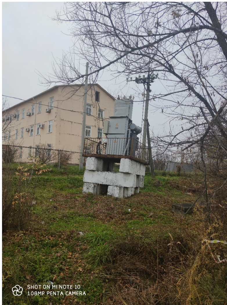
Рис.9 Здание 3КЖ по ул. Котляра. Вид с ж/д путей.
