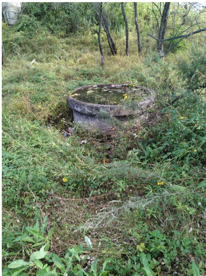
Рис.2 Колодец канализационный
