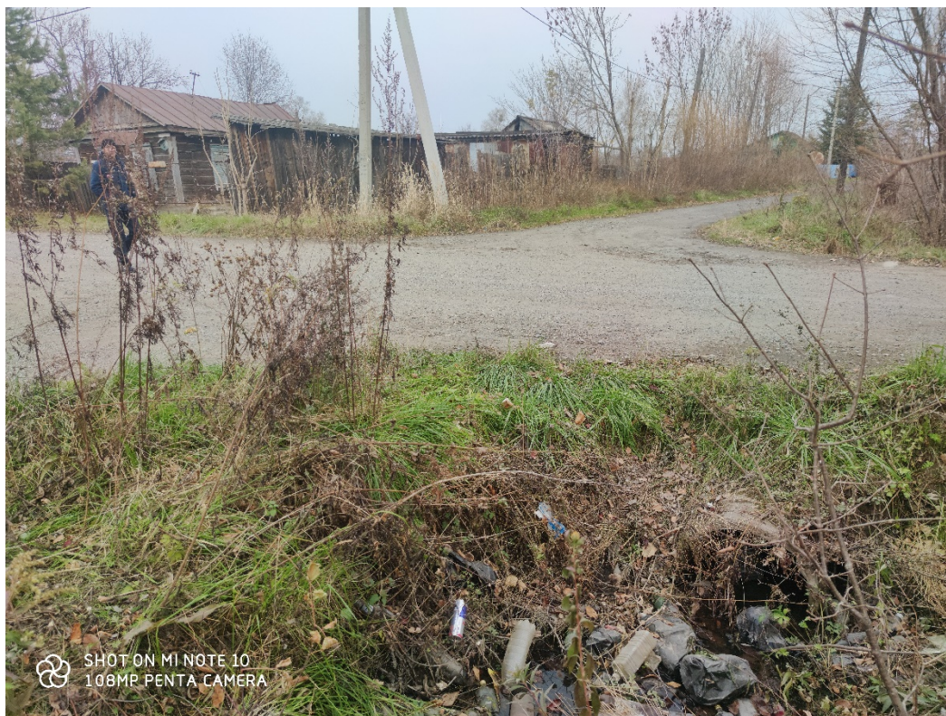
Рис.25 Труба ж/б через ул. Театральная вдоль ул. Партизанская
