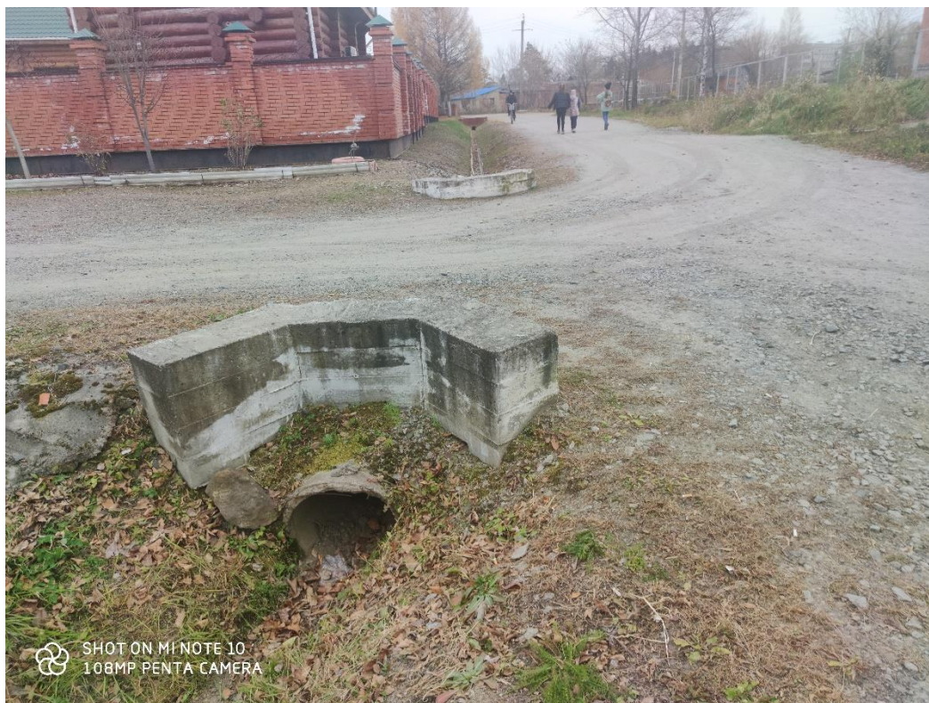
Рис.3 Труба ж/б на улице Казачья
