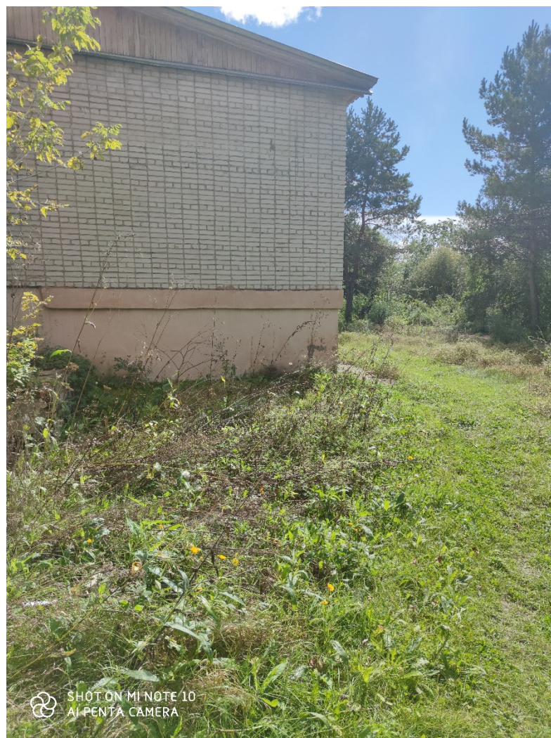
Рис.12 Здание ЗКЖ по ул. Котляра
