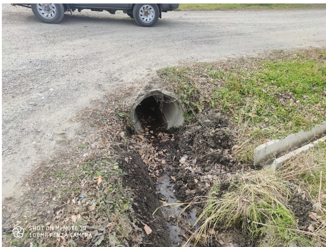
Рис.26 Труба с лотком на перекрестке улиц Театральная и Партизанская
